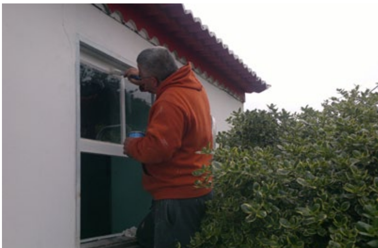
BAIRRO CONDE DE SIMAS - Pintura de portas e janelas.
