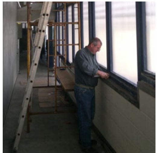
PAVILHÃO MUNICIPAL - Recuperação da fachada principal.
