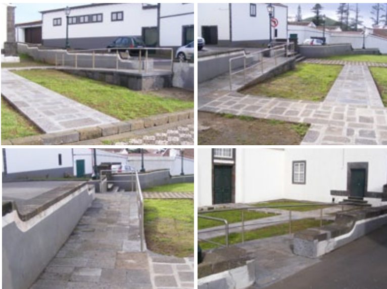
IGREJA DA MATRIZ - Conclusão da rampa para pessoas com mobilidade reduzida.
