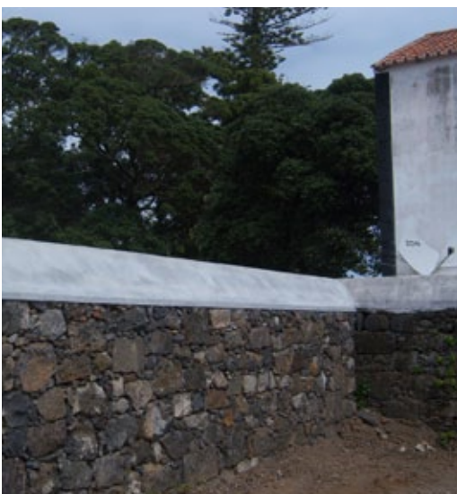
PRAÇA DE SÃO FRANCISCO - Construção de muro divisório entre o terreno adquirido pelo Município e o terreno do antigo proprietário e colocação de calçada.
