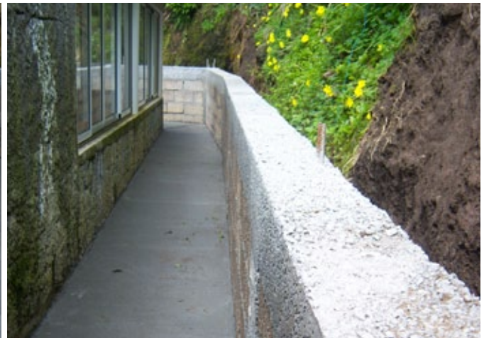
LUZ - Construção de muro a fim de evitar derrocadas e infiltrações no edifício pertencente à Junta de Freguesia da Luz.
