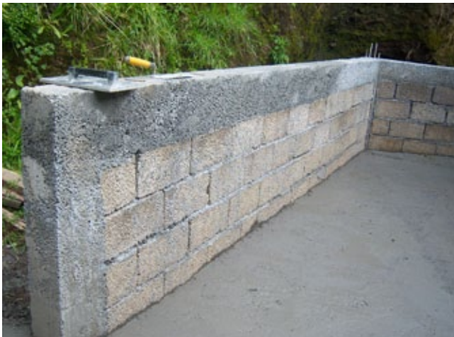
LUZ - Construção de muro a fim de evitar derrocadas e infiltrações no edifício pertencente à Junta de Freguesia da Luz.
